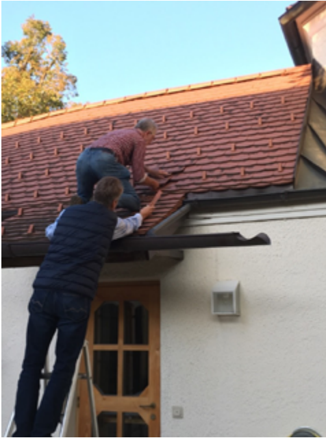
Steigen der Kirche aufs Dach: Michael Ledig und Oliver Michael reparieren einige lose Dachschindeln in einer Pause am Kirchenvorstandstag im Oktober
